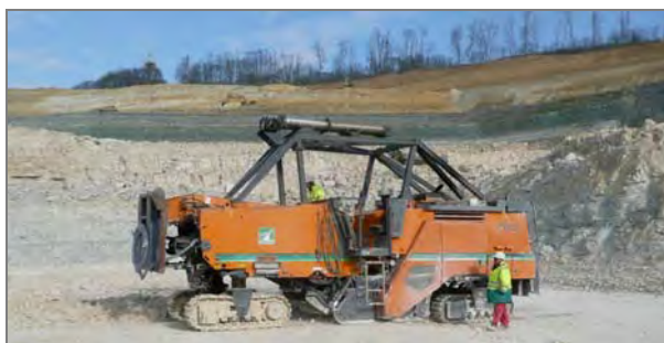
Raboteuse dans la carrière de Cormeilles (source Placoplatre)
