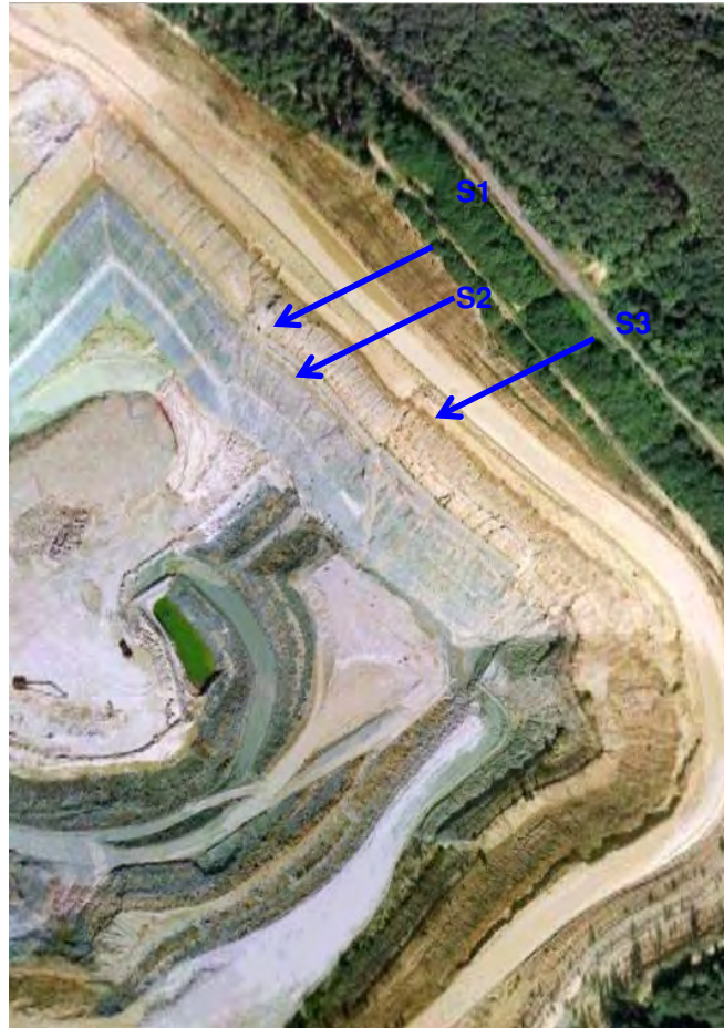
Figure 5 : Vue aérienne de la Carrière Placoplatre, lignes de sources.
