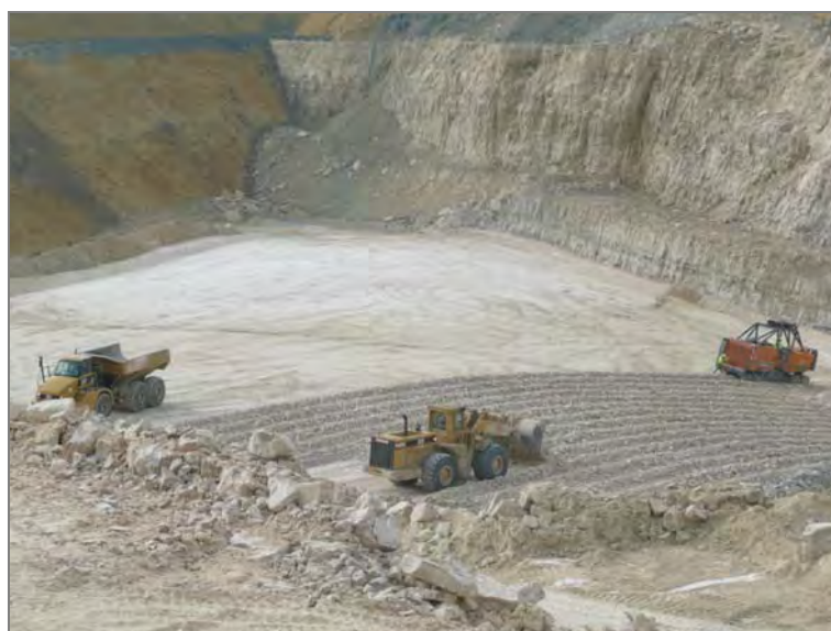
Rabotage de la II ème masse de gypse au fond de la carrière de Cormeilles, avec reprise du gypse extrait à la chargeuse (source Placoplatre)
